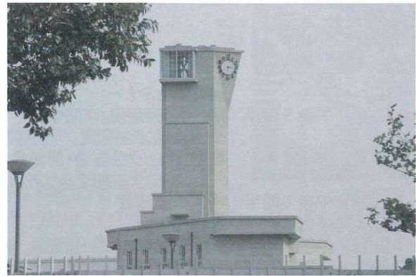
旧小菅刑務所 管理棟
