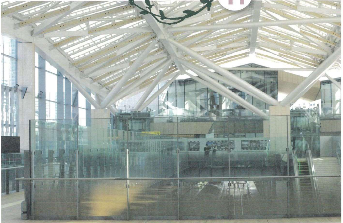
高輪ゲートウェイ駅構内(港区)
