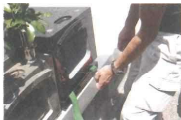
5. 最新の注意を払いながら設置します。
