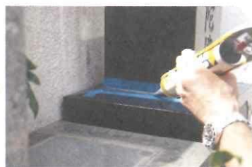
8. 水漏れしないように、石と石の隙間をコーキング材で埋めていきます。
