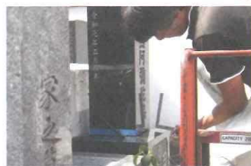
7. 竿石を中心に寄せませす。ミリ単位の繊細な作業です。
