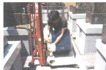
4. リフトに墓石を乗せませす。傷がつかないように慎重に、丁寧に作業されます。
