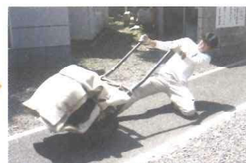
3. 墓石を一輪車に乗せませす。てこの原理で持ち上げます。力仕事です。
