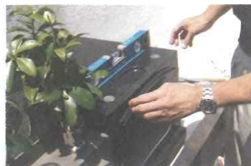
6. 水平を確認します。地味ですが、とても大事な工程だそうです。
