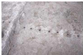
5. 石上部にドリルで等間隔に穴を開けていきます。石の目を見極めて開けているそうです
