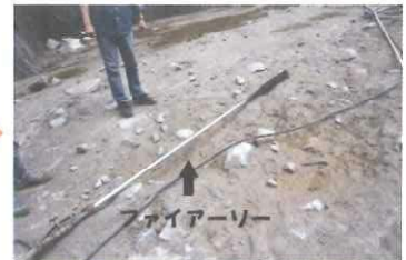
3. 石の底辺はダイナマイトで爆破し、側面はファイアーソー（火の鋸）で切り出します
