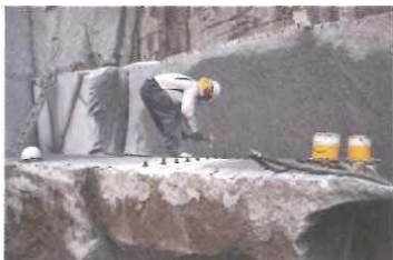
6. 開けた穴にハンマーで鋳を打ち込みひびを入れます。この辺りは全て手作業です
